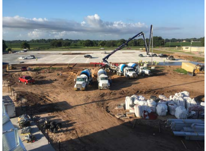
8. Concrete paving pour at home parking
